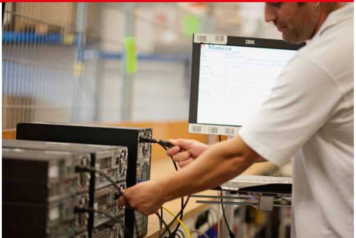
Arbeit an IT-Datenlöschung
